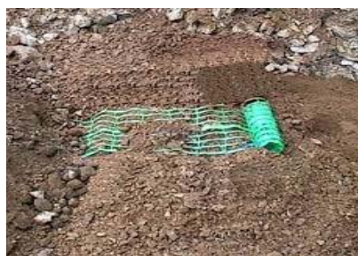
Grillage avertisseur vert – Equipement souterrain
